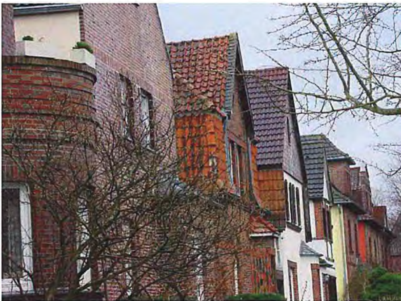
Gesamtansicht, Blick nach Süden
